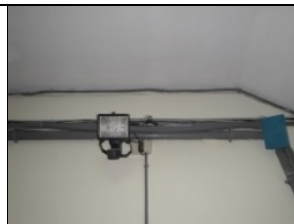
設置自動照明設備，維護出入的安全。
