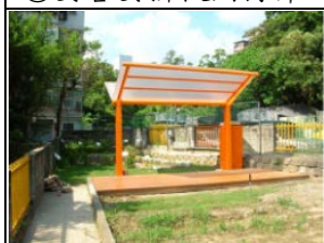
太陽能供電給水設施。
