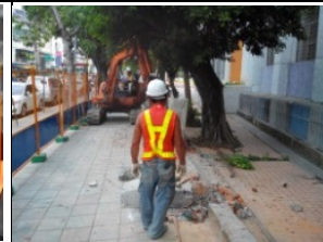
施工強調勞工安全衛生。
