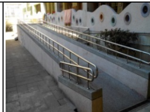
無障礙斜坡道。
